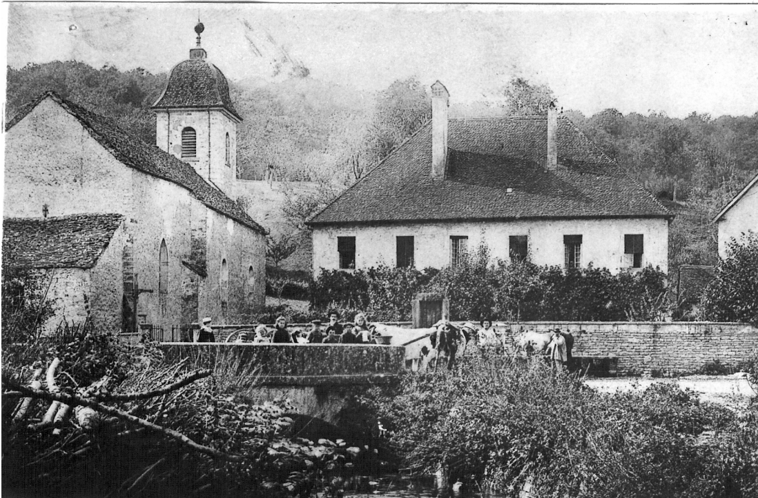
Vue de l'église de Blussans vers 1910, à remarquer sa couverture "en laves". Au centre le presbytère construit en 1700. À droite une partie de la maison d'école. Le petit pan de toit entre les deux est la couverture de l'ancien corps de garde.
